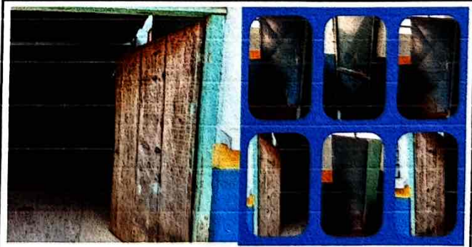
Foto 6: Sustitucion de puertas.
