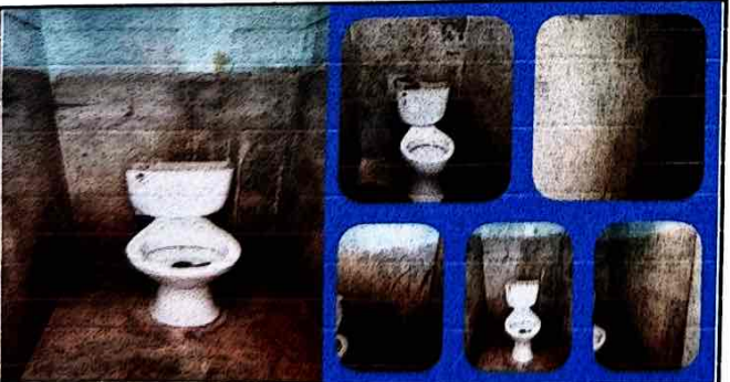
Foto 5: Sustitucion de baños en mal estado.
