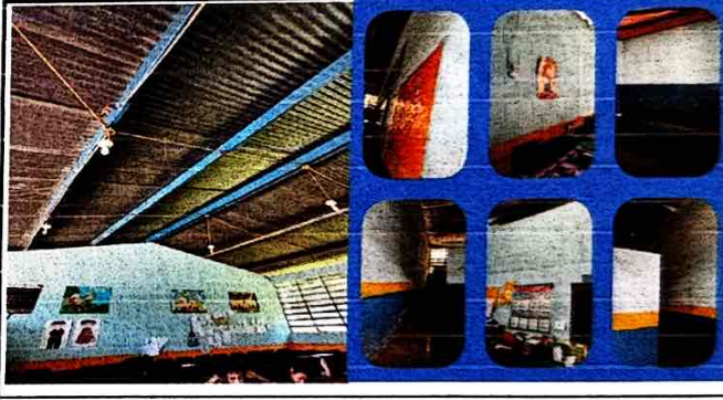
Foto 4: Sustitución de pintura en paredes interior y exterior. Sustitucion de bombillas.
