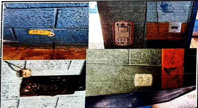
Foto 3: Sustitución de tomacorrientes y apagadores en las aulas y dirección por deterioro.
